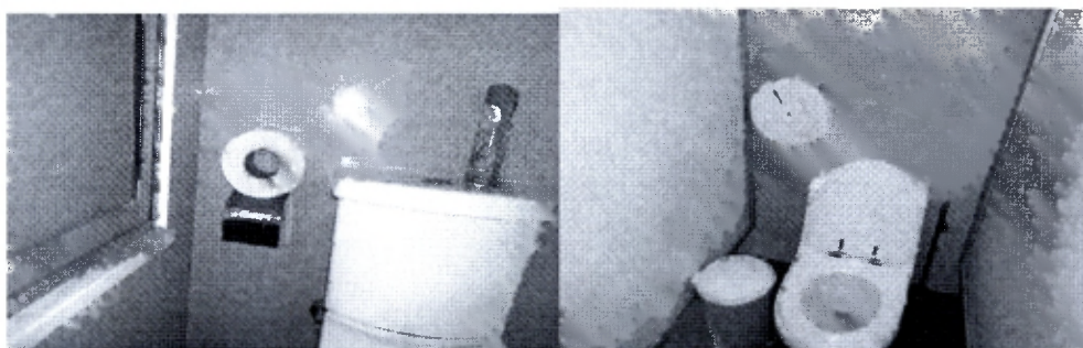
Fotografía N° 1 Dispensador de papel higiénico baño piso 2.
