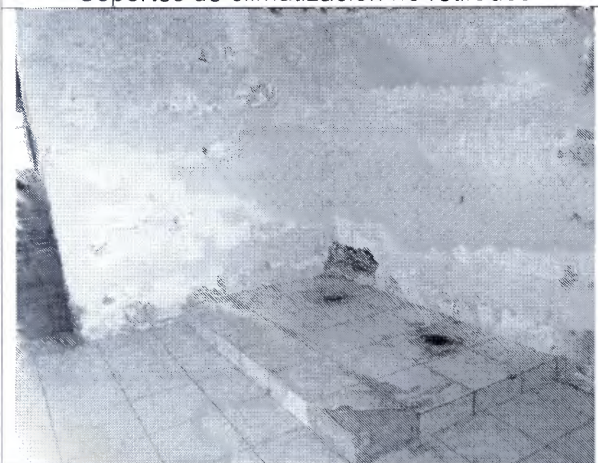
Sobre losa no demolida
