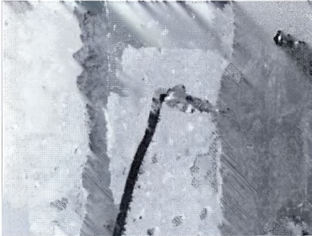
Tuberías no retiradas
